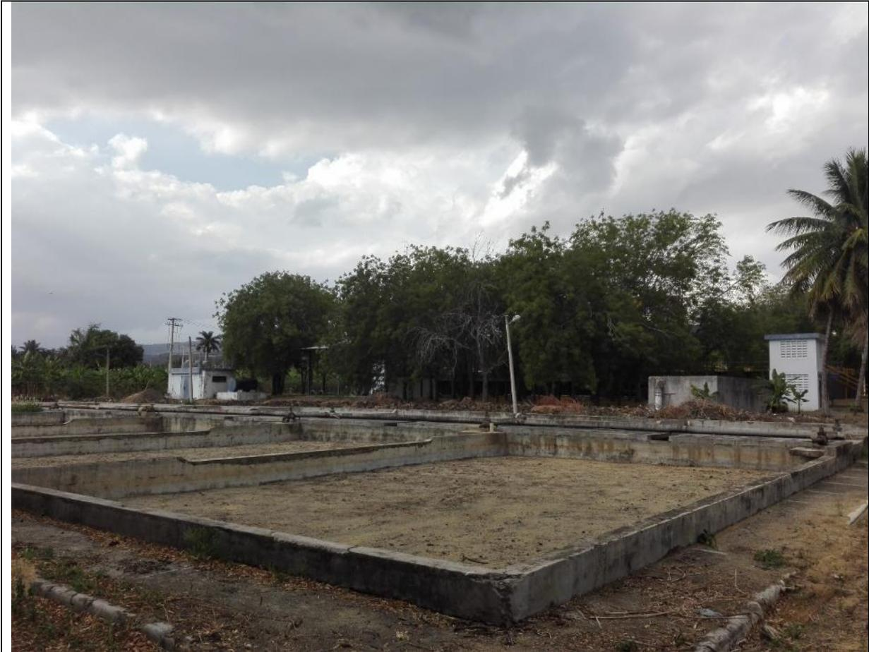
Fotografía del área de secado de lodos
