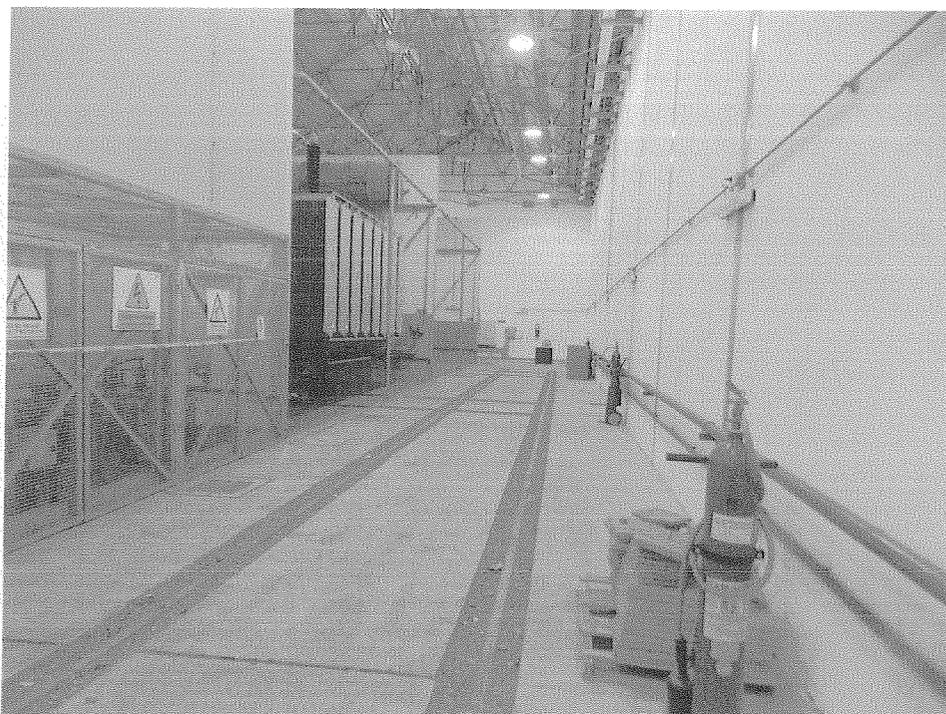
Fotografía 8 Playa cubierta de 132kV con equipos de antiincendio.
