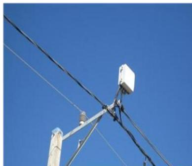
**Medida Técnica Anti hurto Especial:** Red de distribución de electricidad en media tensión (MT) sin red BT y acometidas derivadas desde cajas montadas en la cruceta.
