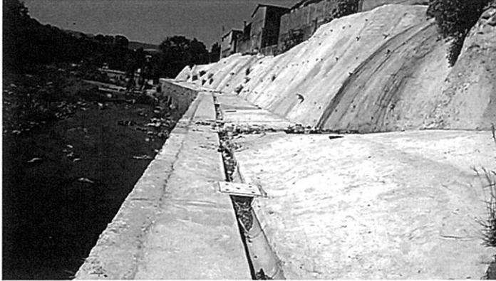
Vista de longitud del muro con terraza cubierta con superficie terminada de cemento y taludes estabilizados y protegidos con mezcla de cemento reforzada con malla electrosoldada
