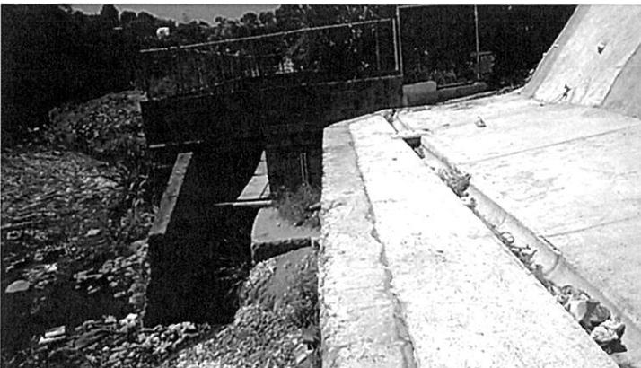
Sección del Muro colindante Comunidad El Granjero con remate de muro 1.7 mts e inicio de canaleta de aguas lluvias
