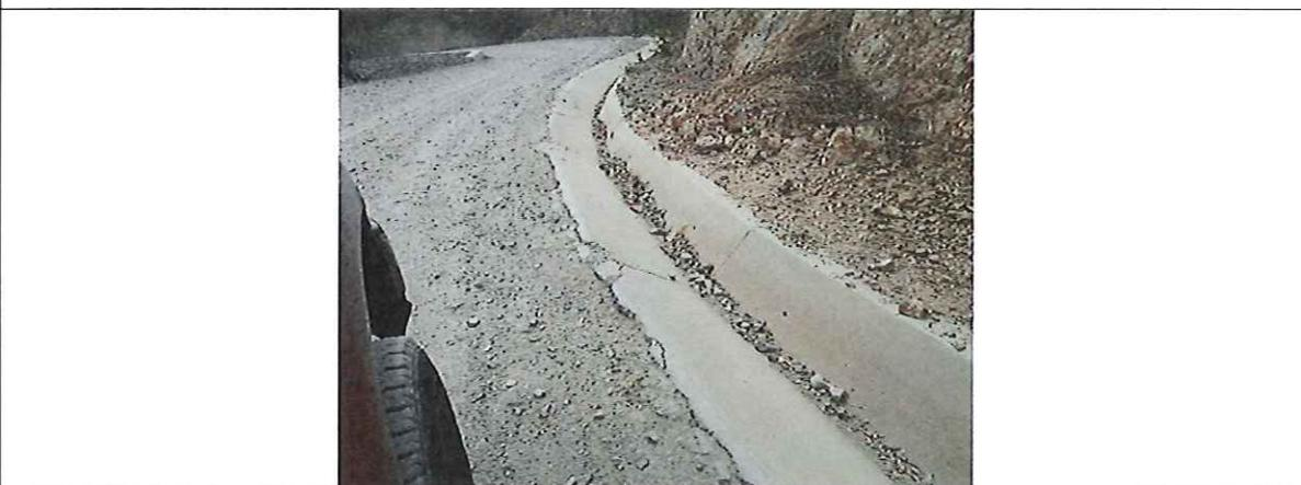
Fotografías que muestran tramo donde puede apreciarse las canaletas construidas
