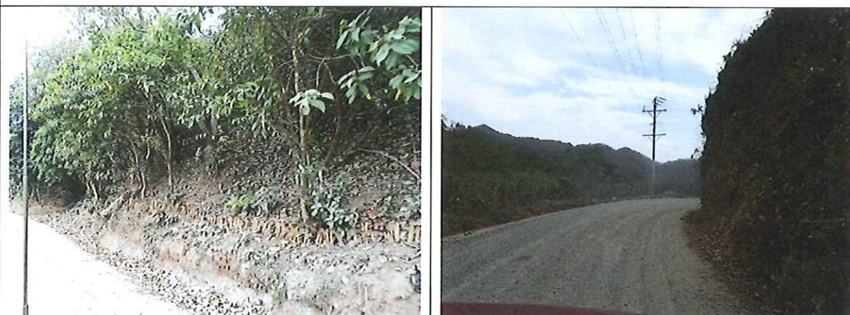
Fotografías que muestran sectores con barreras vivas de zacate vetiver todavía en buen estado y la condición de la calzada en muy buen estado.
