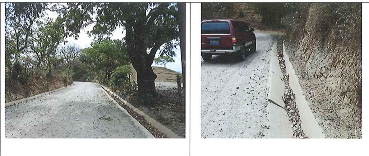
Fotografías que muestran drenaje longitudinal (Cunetas)
