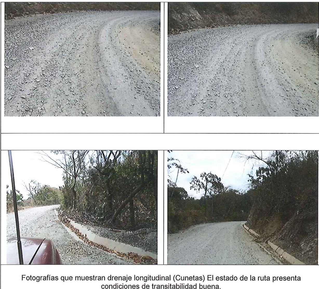
Fotografías que muestran drenaje longitudinal (Cunetas) El estado de la ruta presenta condiciones de transitabilidad buena.
