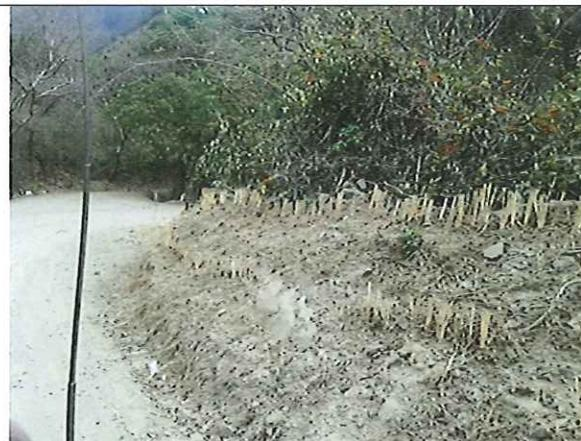
Fotografías que muestran la calzada en muy buenas condiciones de transitabilidad. Puede apreciarse barreras vivas de zacate Vetiver
