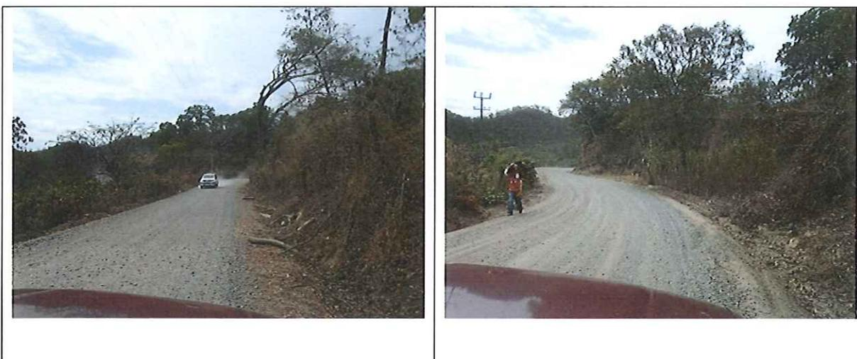
Fotografías que muestran drenaje longitudinal (Cunetas)
