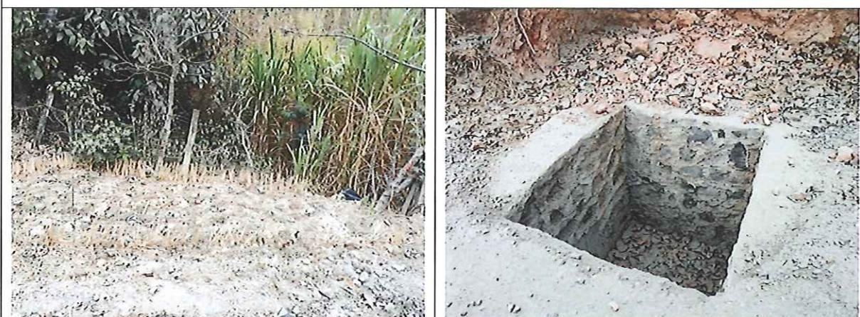
Fotografías que muestran sectores con barreras vivas de zacate Vetiver todavía en buen estado, y cajas de tuberías transversales
