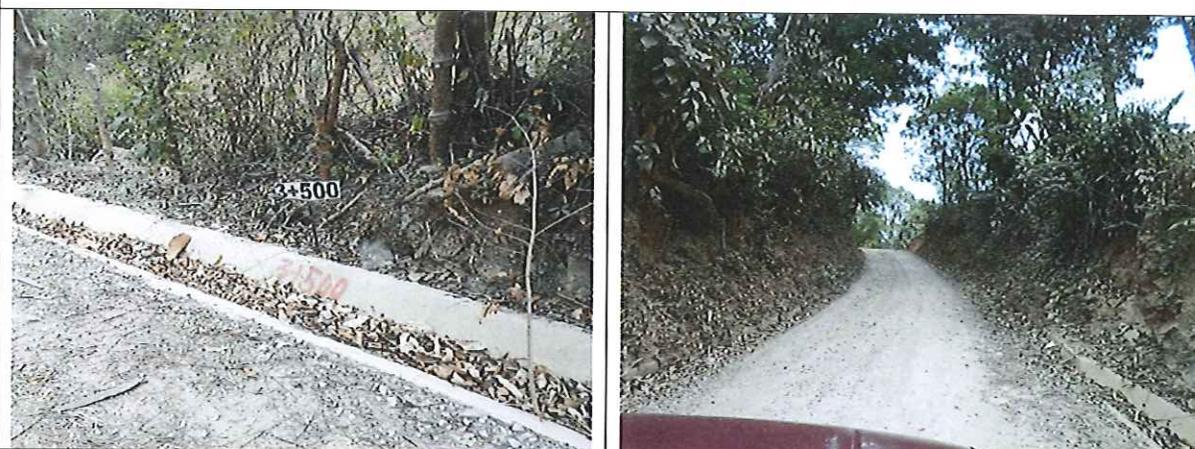
Fotografías que muestran drenaje longitudinal (Cunetas). El estado de la ruta presenta condiciones de transitabilidad buena.
