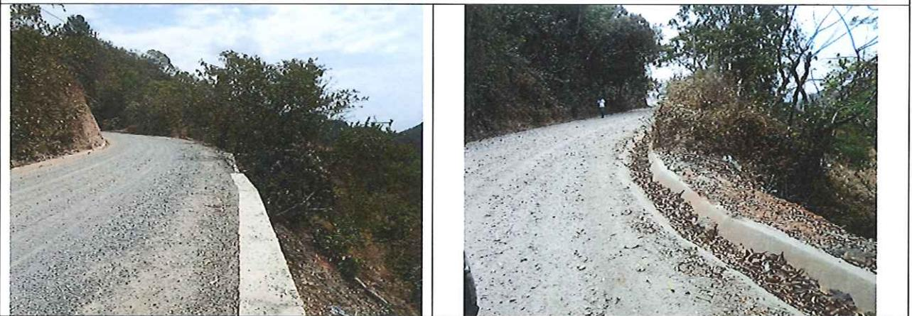
Fotografías que muestran drenaje longitudinal (Cunetas)
