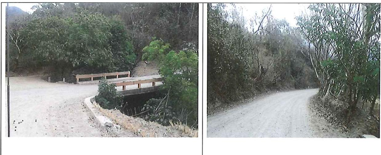
Fotografías que muestran tramos con material grueso segregado generado por pérdida de finos. Puede apreciarse barreras vivas de zacate vetiver en buen estado
