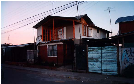
Figura 60: Vivienda de dos pisos, Población Moreira Castillo, Paine
