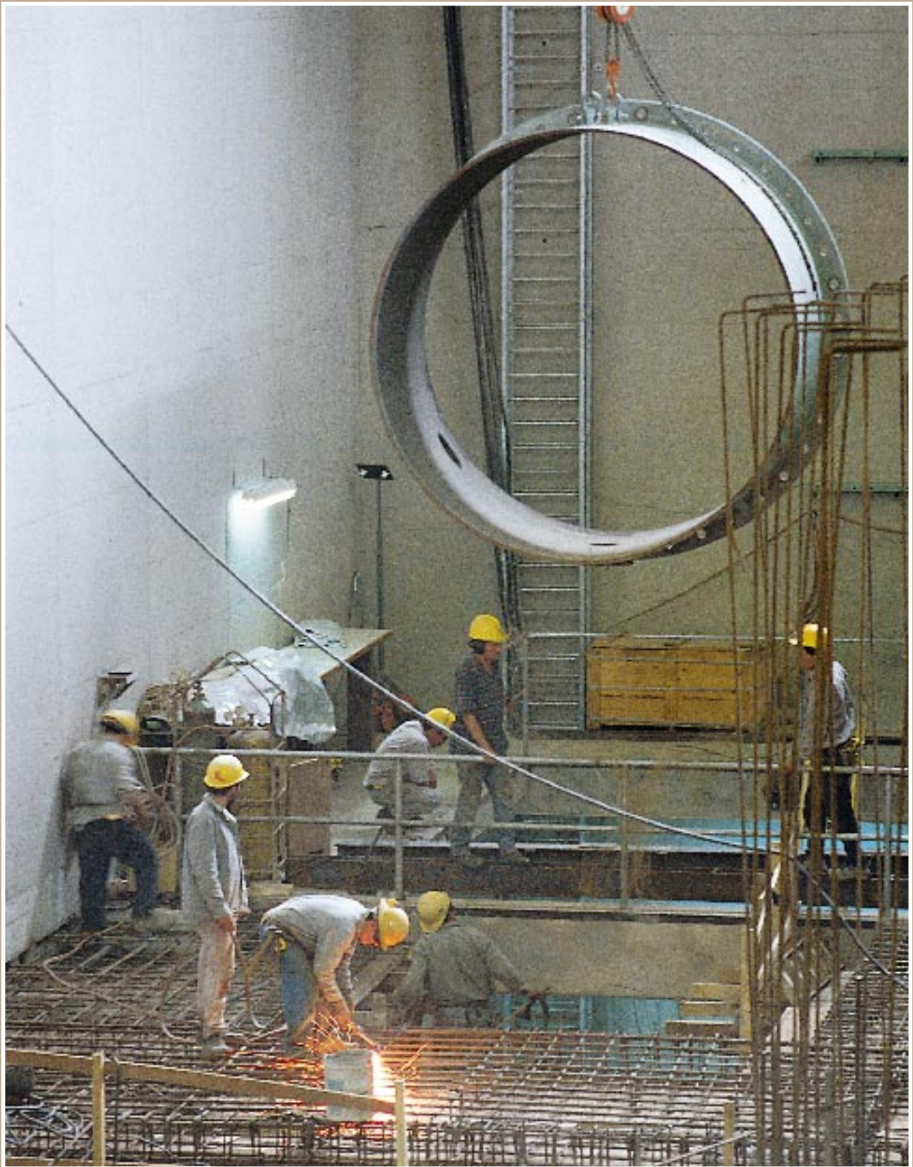
COSTA RICA—Instalación de tuberías en la casa de máquinas del proyecto hidroeléctrico de Angostura, Turrialba, financiado por el Banco como parte de un programa de desarrollo energético.
