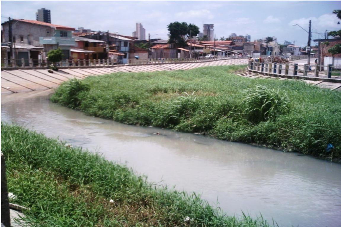
Alto nível de assoreamento na convergência do Canal da Av. Visconde de Inhaúma para o Canal da Trav. Antônio Baena, no bairro de Fátima, Sub-bacia I do Projeto Una.
