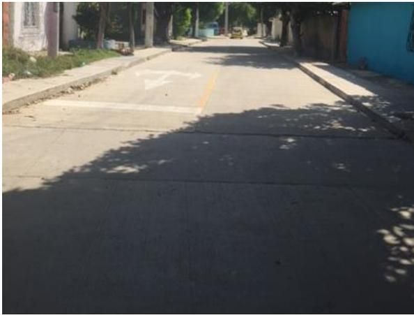
Fig 10– Calzada de loza rígida de concreto en Los
