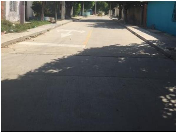
Fig 10– Calzada de loza rígida de concreto en Los Olivos
