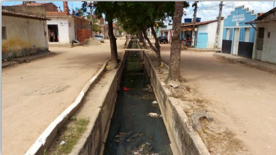
**Figura 57:** Canais de drenagem levam o esgoto in natura diretamente para a laguna Mundaú.
