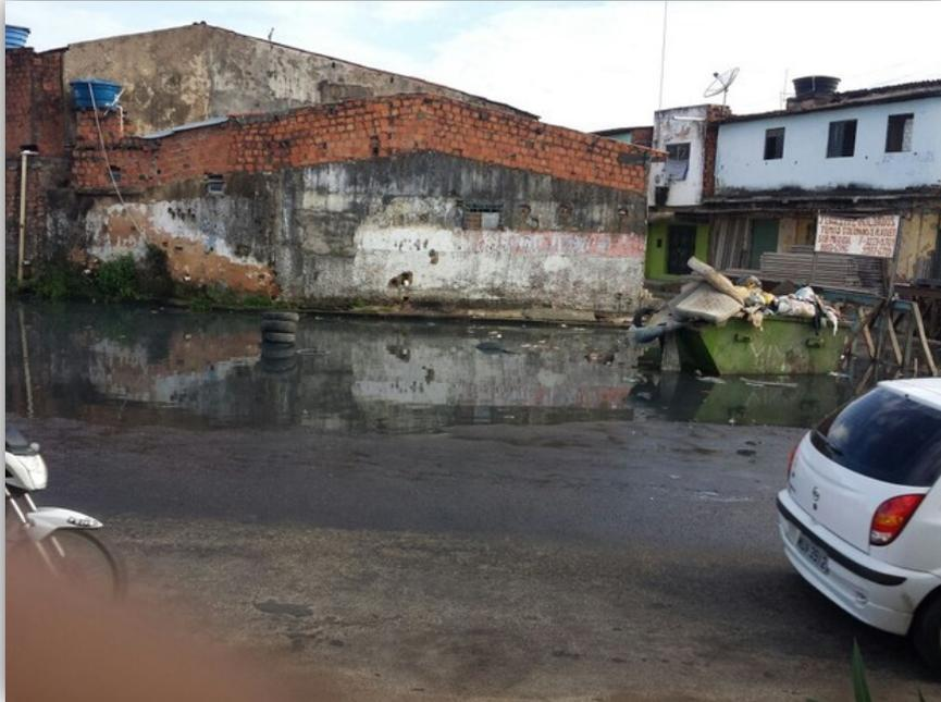
**Figura 19:** Trecho da ADA, na Avenida Senador Rui Palmeira, próximo ao canal da Levada. A área sofre periodicamente com trasbordos, principalmente na maré alta, devido ao asfalto da via está abaixo do nível da Laguna. Foto: Heliana Gonçalves/TV Gazeta, (Abril de 2015).
