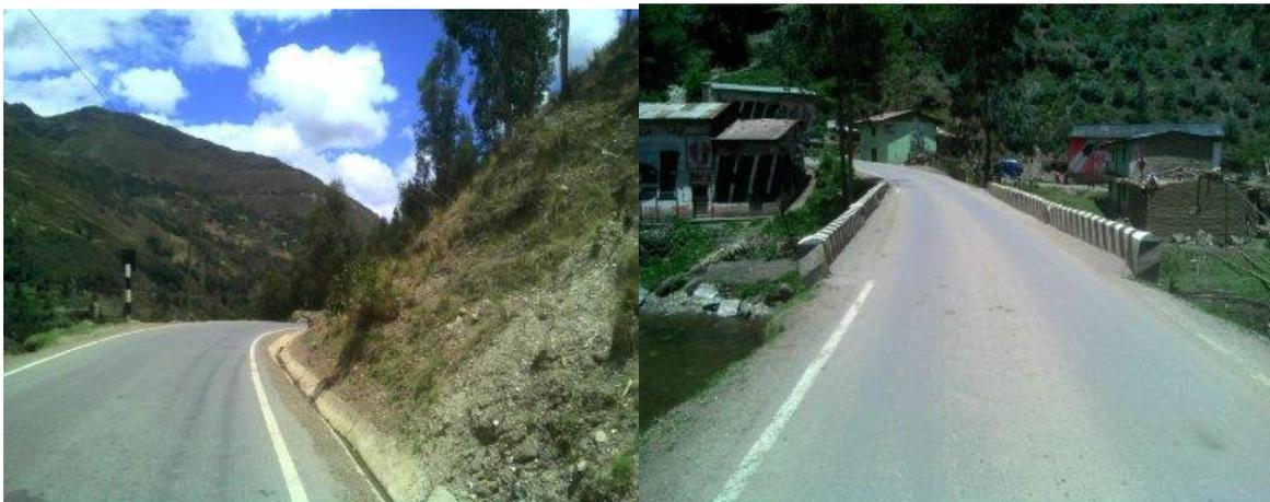
*Presencia de cunetas revestida en un tramo de 200 m. a la salida de Chavinillo.*
