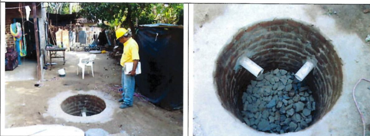
Fotografías que muestran personal del contratista en la construcción de pozo resumidero para el sistema de Séptico implementado en los lotes intervenidos con el proyecto
