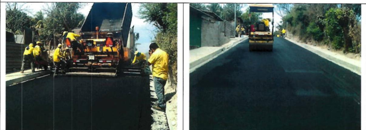
Fotografías que muestran personal del contratista en la colocación de mezcla asfáltica en calles y pasajes de la comunidad. El Castillo II
