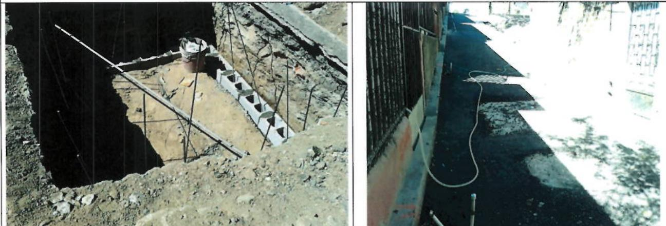
Fotografías que muestran Construcción de Cajas de válvulas sobre Calle Principal de Colonia Istmania I. Construcción de carpeta asfáltica en Calle San Ramero, Colonia dolores Medina.
