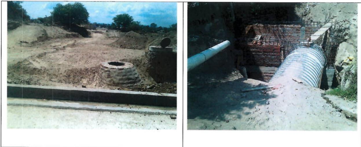
Fotografías que muestran personal trabajando en tubería de 72" de Aguas Lluvias.
