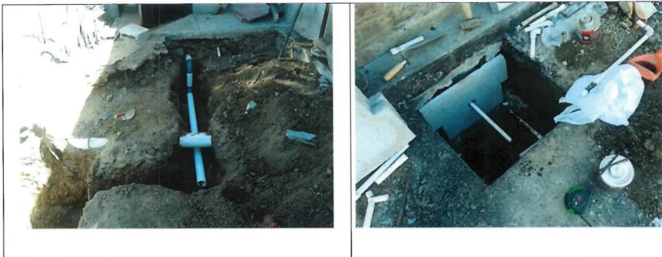
Fotografías que muestran trabajos concernientes a conexión de acometidas domiciliarias y Construcción de Cajas para Medidores de Agua Potable en Calle San Romero, Comunidad Dolores Medina.
