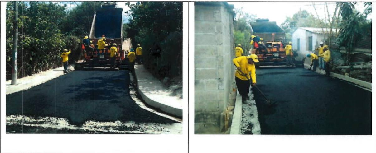
Fotografías que muestran personal del contratista en la colocación de mezcla asfáltica en calles y pasajes de la comunidad. El Castillo II
