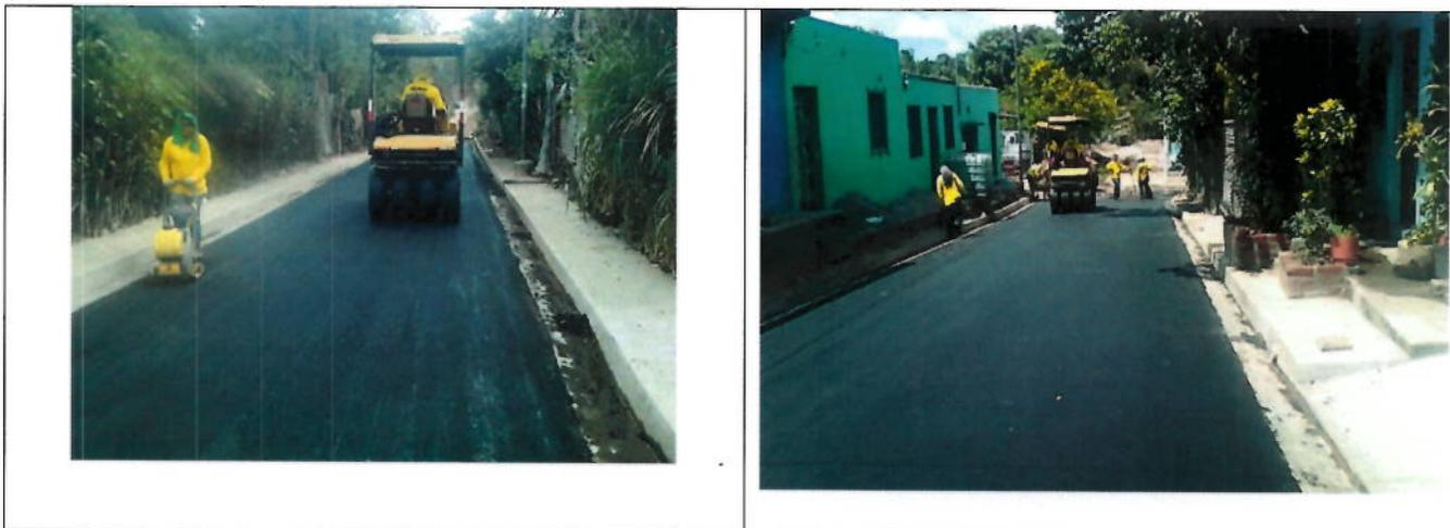
Fotografías que muestran personal del contratista en la colocación de mezcla asfáltica en calles y pasajes de la comunidad. El Castillo II
