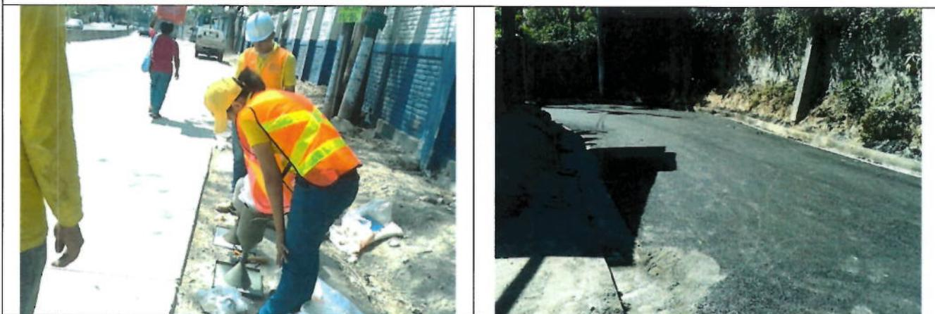
Fotografías que muestran personal del Constructor y la Supervisión realizando toma de densidades en la base cementada para verificar resultados y que pueda procederse a la colocación de concreto tipo acera. Tramo de calle Principal en colonia Istmania I donde se colocó mezcla asfáltica en caliente.
