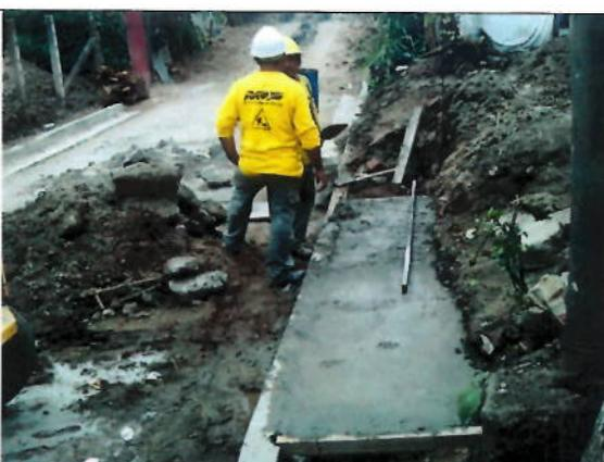
Fotografías que muestran personal del contratista trabajando en la descarga de Aguas Lluvias, forjando las gradas disipadoras de energía derramaderos y cabezales.
