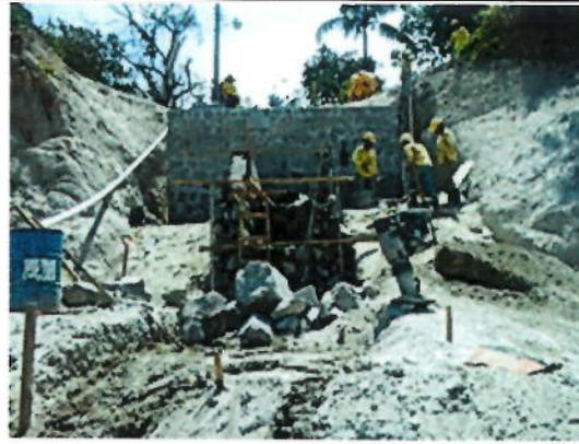
Fotografías que muestran personal del contratista en la construcción de cabezales y gradas disipadoras en tubería de Aguas Lluvias.
