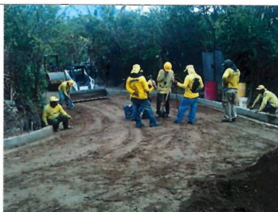
Fotografías que muestran trabajos concernientes a Aguas Negras, construcción de pozo y caja sostén
