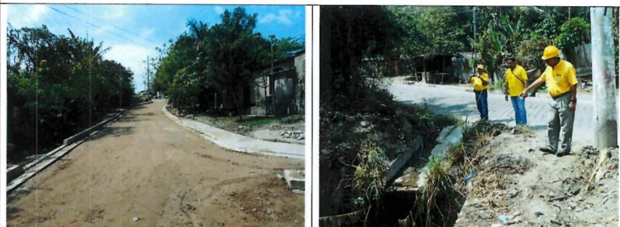
Fotografías que muestran personal del contratista trabajando en la compactación de base de suelo cemento y de evaluación de descarga de aguas lluvias en uno de los sectores críticos sobre la Calle Principal.
