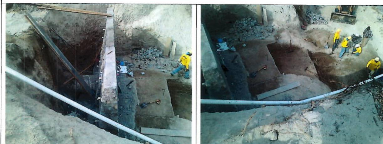
Fotografías que muestran personal del contratista trabajando en la descarga de Aguas Lluvias, forjando las gradas disipadoras de energía derramaderos y cabezales.
