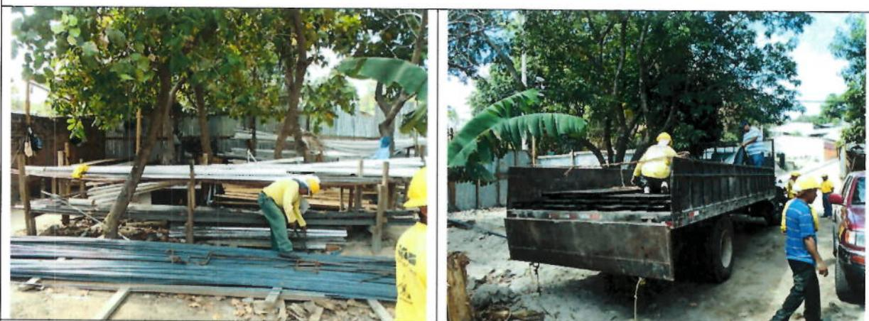
Fotografías que muestran personal del contratista en plantel acopiando materiales de construcción como hierro, polines, tubería PVC de diferentes diámetros y formaletas para construcción de cordón cuneta.
