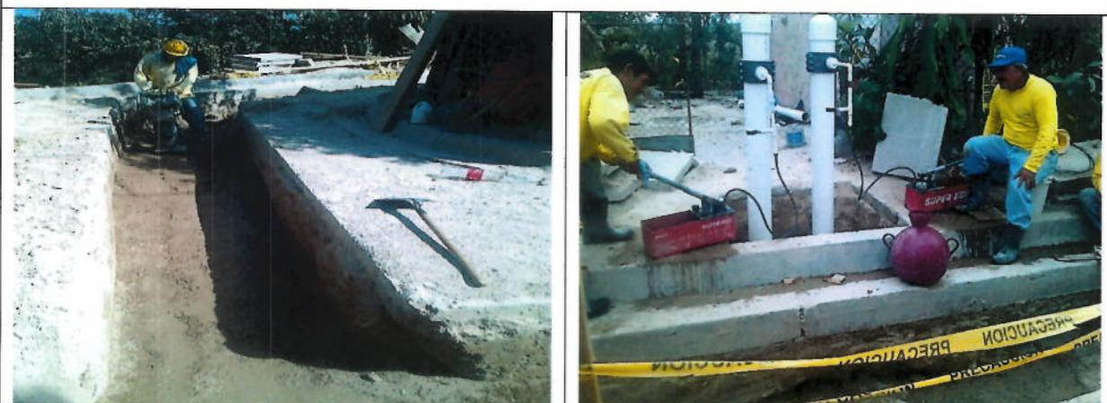
Fotografías que muestran personal del contratista realizando compactaciones de tubería de impelencia en la entrada al tanque, donde se están realizando pruebas de hermeticidad de la misma.
