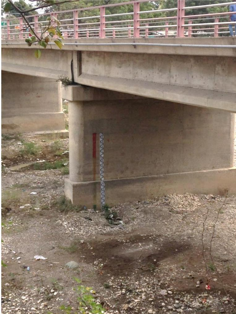
**Photos 3 : échelle limnimétrique sur une pile du pont de la Rouyonne près de Léogane.**
