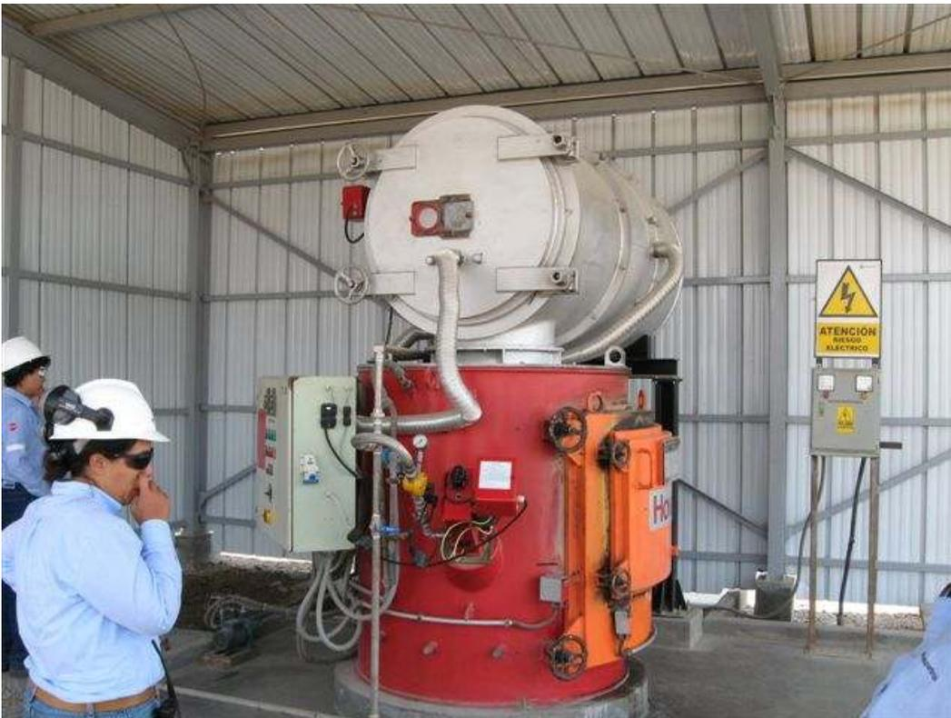
Foto 32: Incinerador de pisco con cámara secundaria.
