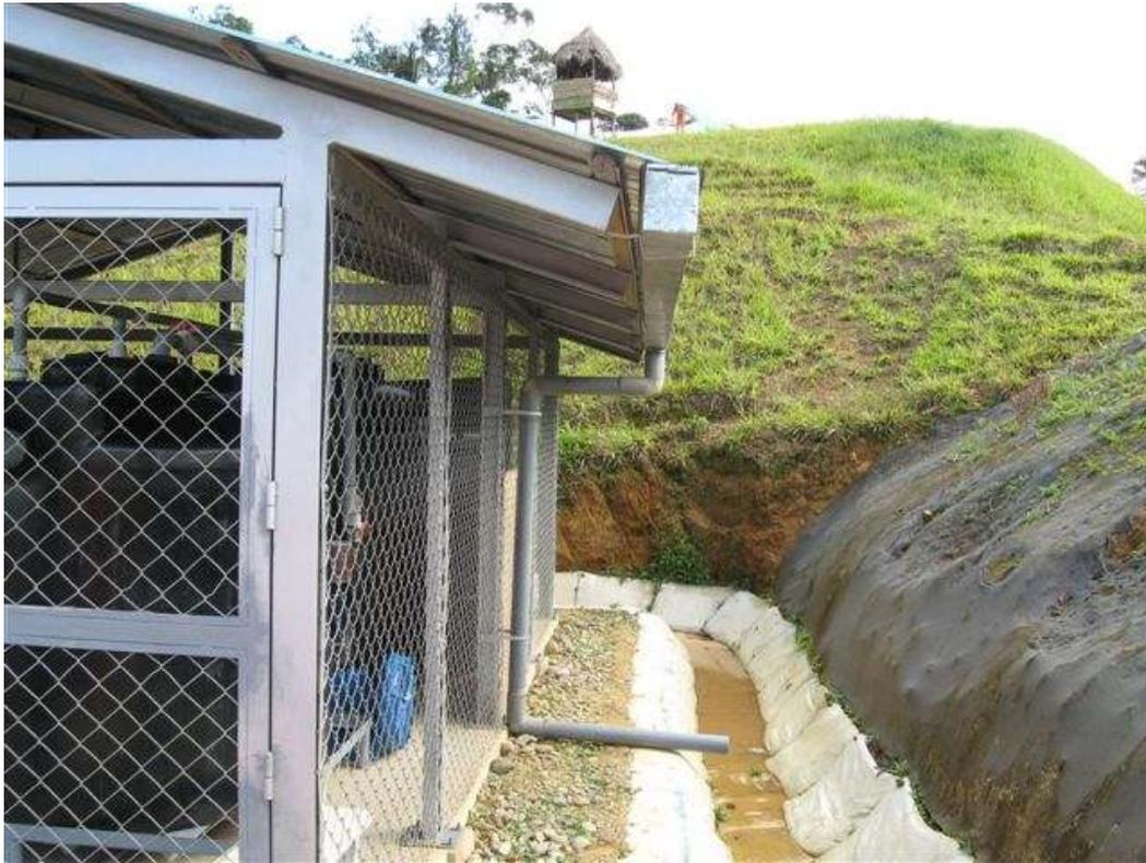
Foto 23: Drenaje de agua de lluvia, secciones horizontales cruzan el pasadizo muy bajo en la parte superior y sobre el suelo en la parte inferior provocando condiciones inseguras.
